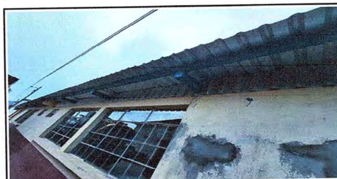
Foto 6: Cerrado de espacios entre techo y pared.
