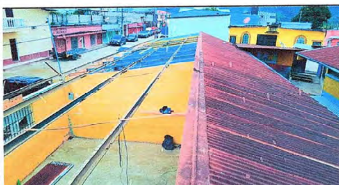
Foto 3: Levantamiento de techo.
