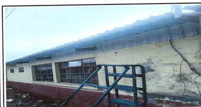
Foto 5: Cerrado de espacios entre el techo y la pared.
