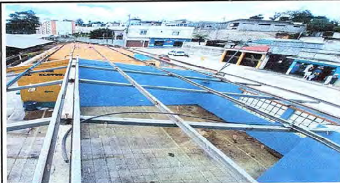
Foto 2: Levantamiento de techo.
