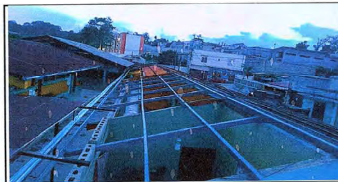
Foto 6: Pintado de costaneras.
