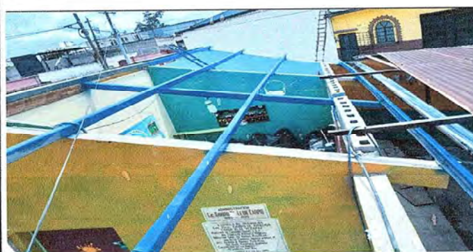
Foto 5: Cambio y pintado de costaneras.
