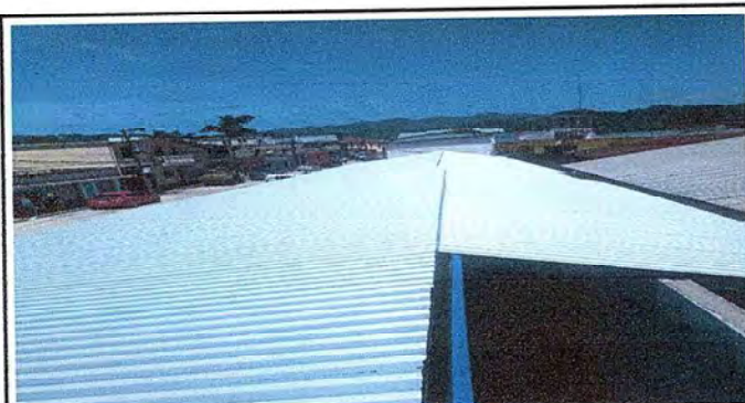
Foto 3: Instalación de techo.
