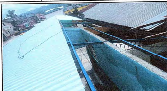
Foto 2: Instalación de techo.
