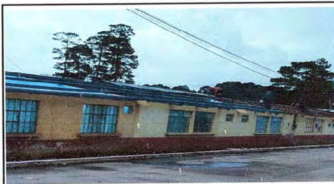
Foto 4: Lijado y pintado de costaneras.
