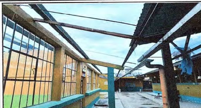
Foto1: Levantamiento de techo.
