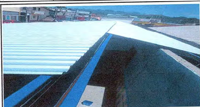
Foto 1: Instalación de techo.
